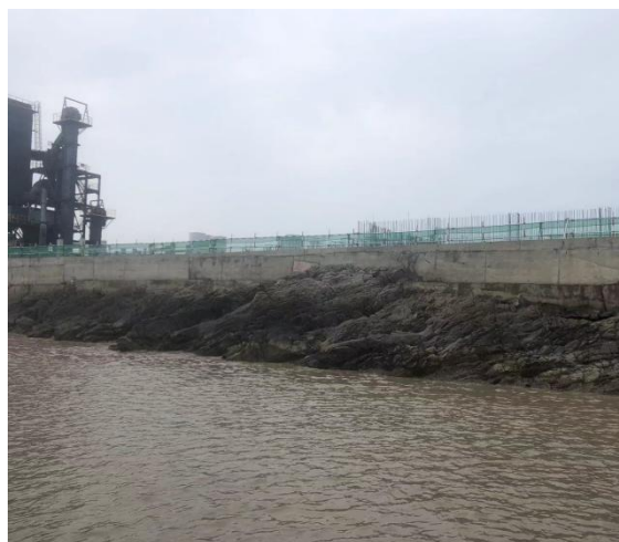
工程起点处海堤
