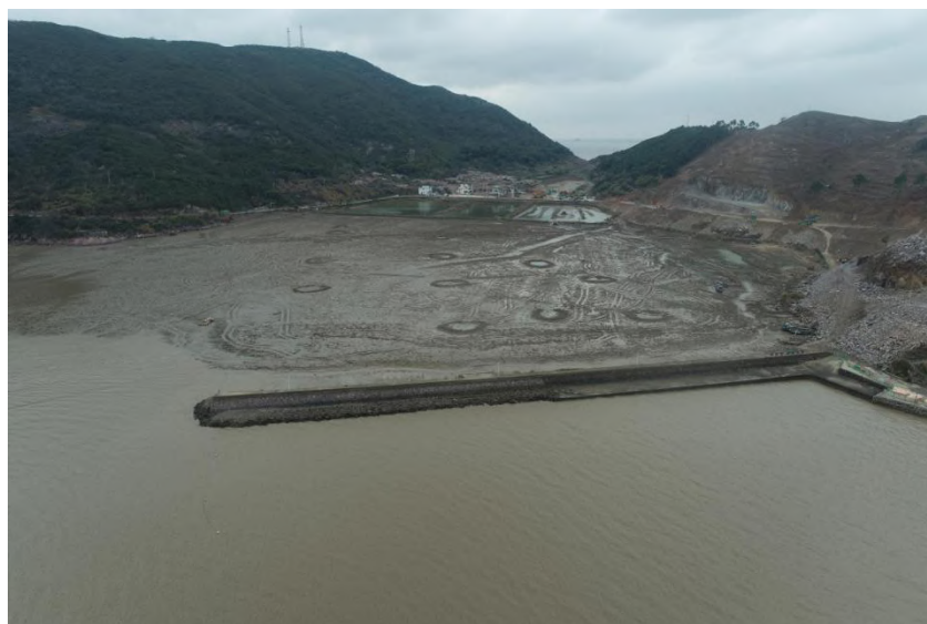
图4.3-6 金七门渔港防波堤（2023年3月）
